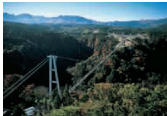
写真：九重夢大吊橋(九重町)
