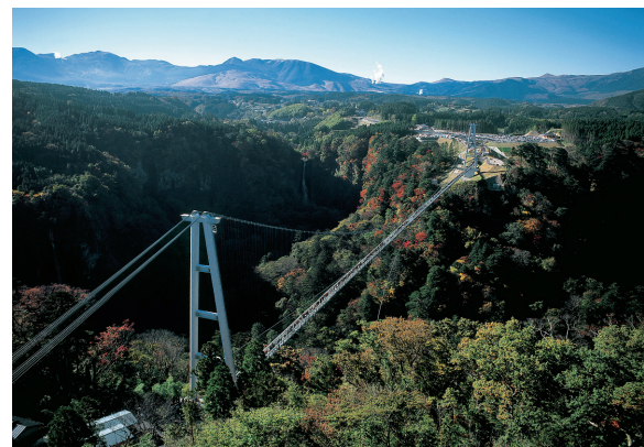
写真：九重夢大吊橋(九重町)
