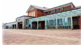
道の駅「きららあじす」
